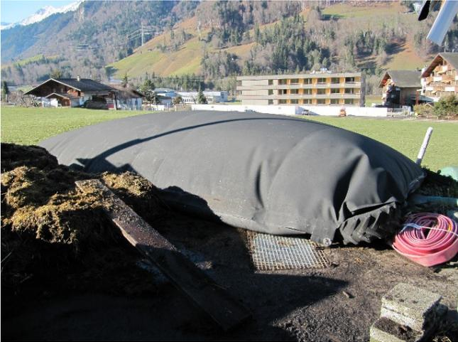
*Das Biogaslager. Der Ballon besteht aus einem speziellen witterungsbeständigen Kunststoff*
